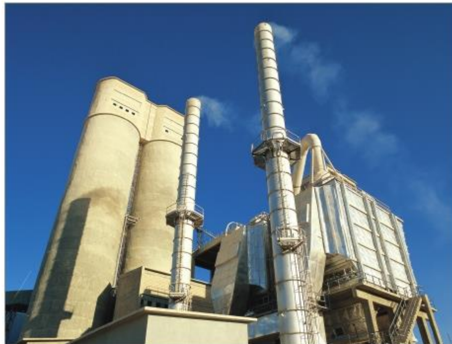
Adıyaman Çimento Fabrikası
